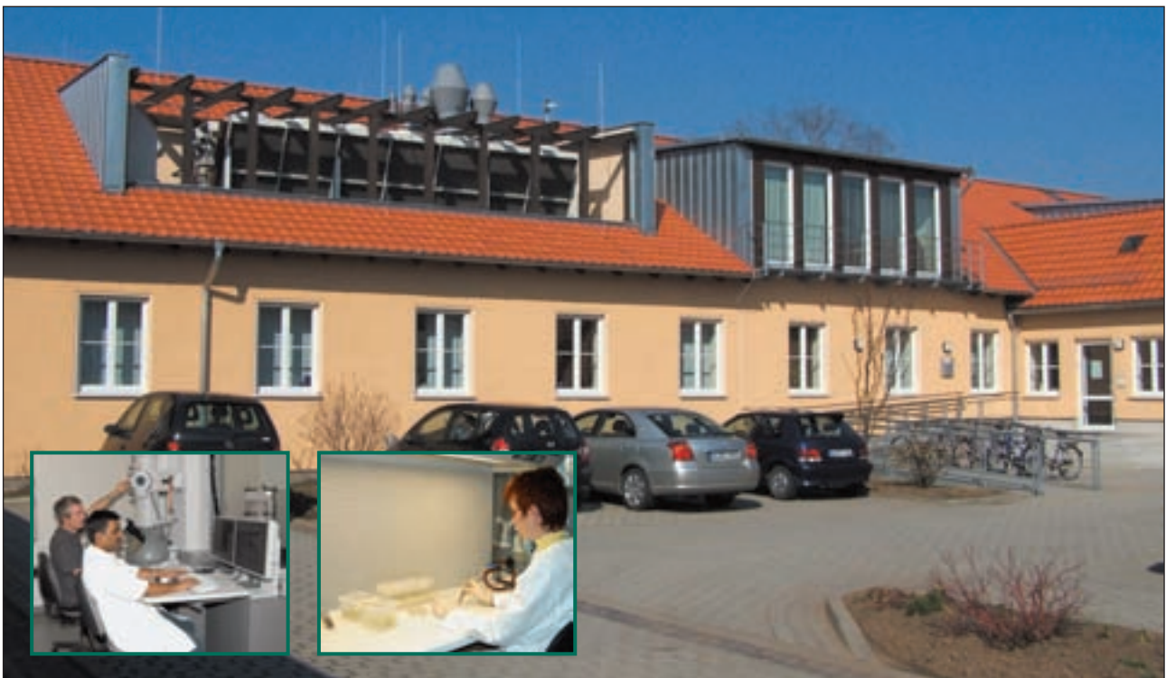
Fig. 10: Durch die Sanierung wurden die Arbeitsbedingungen wesentlich verbessert. Working conditions were considerably improved by the reconstruction of the Friedrich Miescher Building (Foto: B. Schäfer, K. Engelmann).
