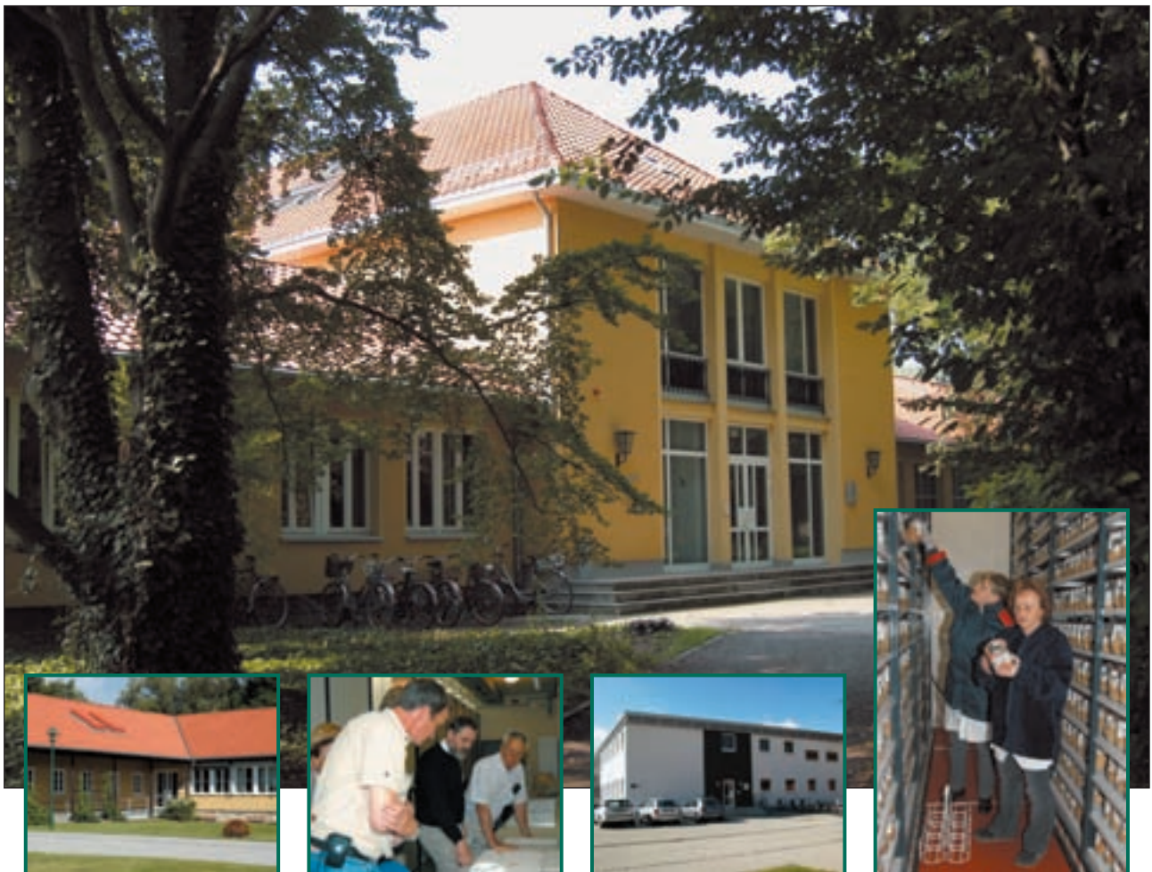
Fig. 9: Das Vavilov-Haus bietet nach Abschluss der Sanierung beste Bedingungen, um Kulturpflanzenforschung zu betreiben (Foto: B. Schäfer). After finished reconstruction, the Vavilov House will provide excellent conditions for crop plant research (photo: B. Schäfer).
